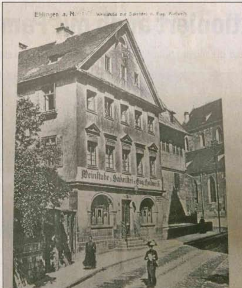
Einst beherbergte das Gebäude eine Weinstube namens „Zur Sakristei“. Typisch sind die Rundfenster im Erdgeschoss. Fotos: oh
