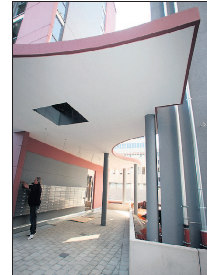
Der Eingangsbereich verbindet den Neubau mit dem Altbau.
