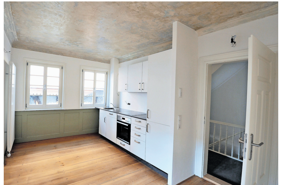
In mehreren Räumen kamen alte Stuckdecken zum Vorschein. Die breiten Dielen auf dem Boden stammen ebenso aus früheren Jahrhunderten wie die Wandvertäfelung.
