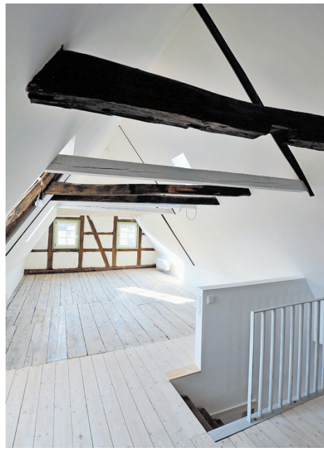
Im Dachstuhl sind rußgeschwärzte, naturkrumme Dachsparren aus Pappelholz sichtbar. Sie stammen von 1443.
