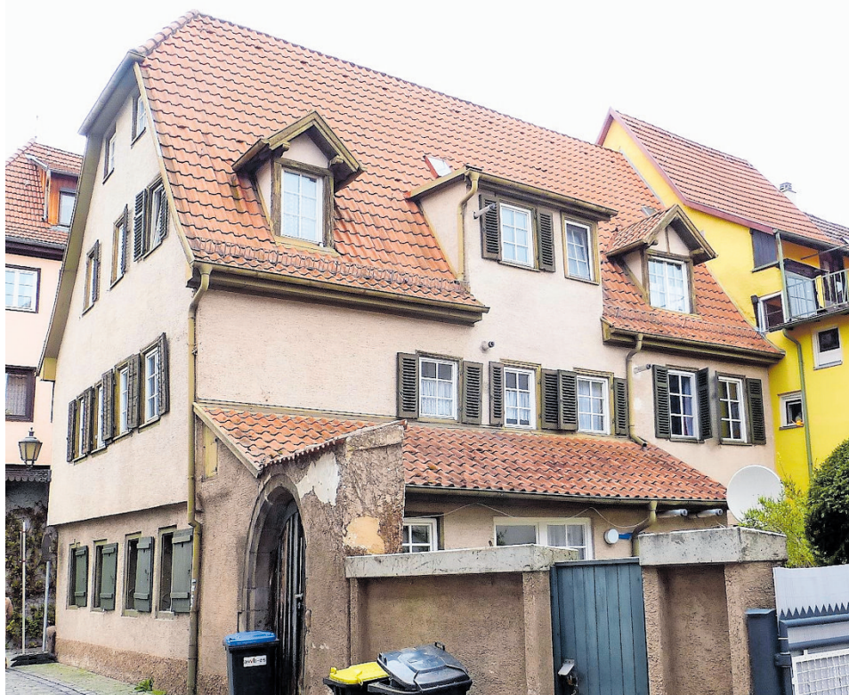
Vor der Sanierung war das Haus ziemlich in die Jahre gekommen.
