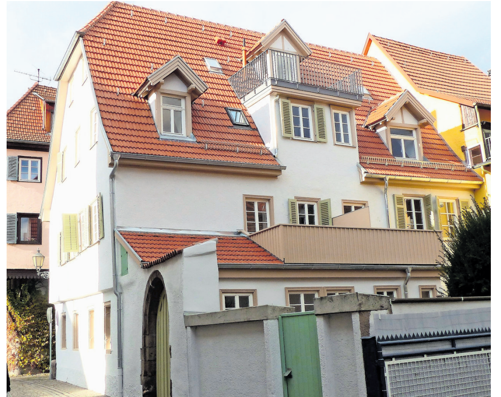
Mit der Sanierung bekamen die Wohnungen in den Obergeschossen Balkone.
