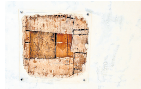
So sieht es über der Stuckdecke aus: Holz, Stroh und Lehm. Foto: Kaier
