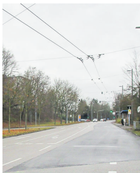
Hier wird demnächst saniert.
