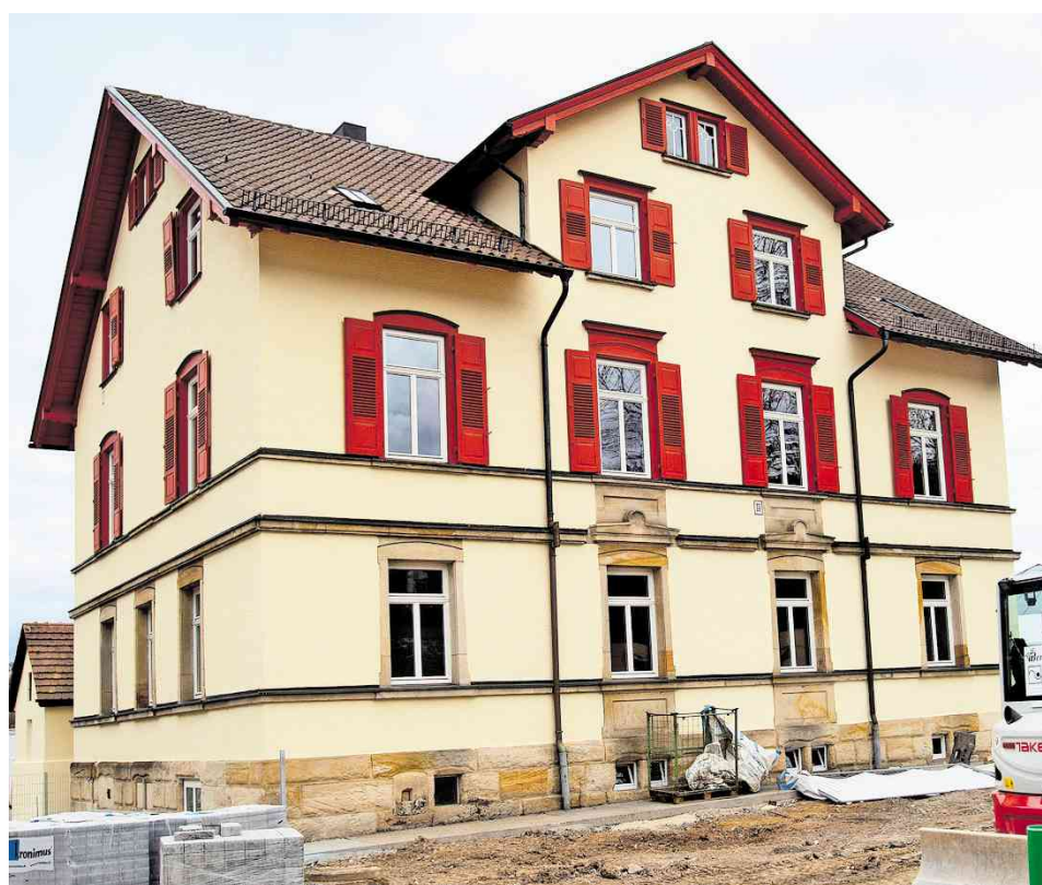
Außen glänzt das Gebäude Stuttgarter Straße 2 nun mit seinen roten Fensterläden. Die Außenanlage ist noch im Werden. Fotos: Ines Rudel
