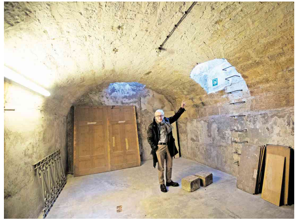
Im Gewölbekeller könnte künftig ein Probenraum für Bands entstehen.
