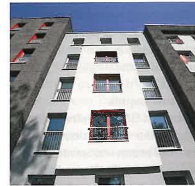
2 Die wenigen tragenden Wände wurden in Massivbauweise und mit einem WDVS errichtet, der Großteil der Wände entstand im Trockenbauverfahren.
