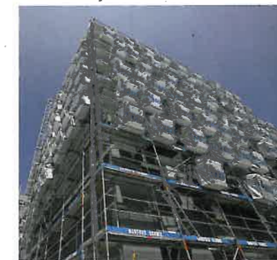
5 Das Imbag-System stellt das Material dort zur Verfügung, wo es gebraucht wird. Darüber hinaus sorgt es für mehr Platz am Boden.
