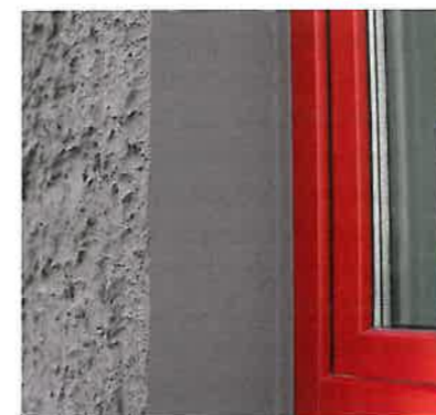
4 Die auffällige grobe Oberflächenstruktur des Putzes wird mit einer Glättkelle erzeugt.
