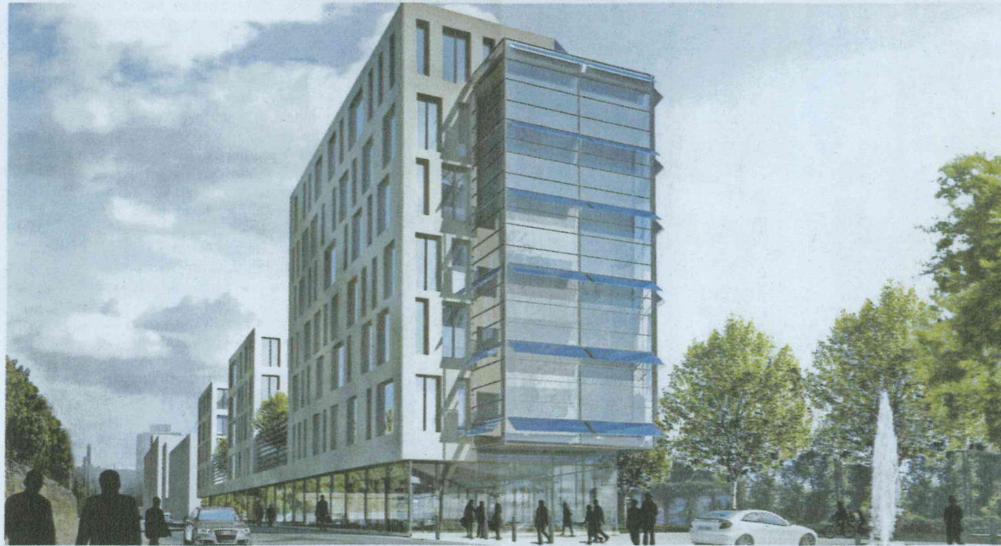
An der Spitze des Hengstenberg-Areals errichtet die EWB ein Bürohaus mit 8.500 m 2 Nutzfläche.
